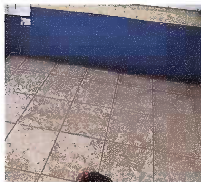
Foto 4: Sustrucción de piso de torta a piso cerámica.
