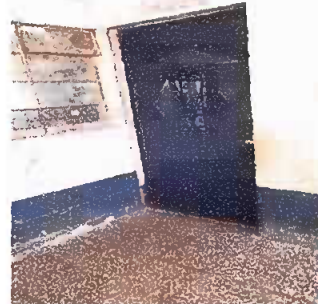
Foto 2: Sustrucción de puerta de madera a metal.
