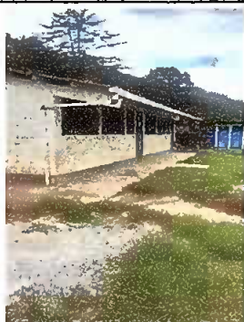
Foto 5: Sustrucción de canal de Pvc
