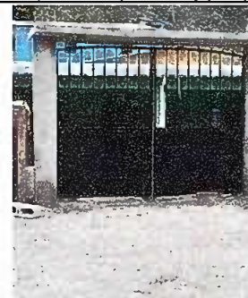
Foto 6: Sustutución del portón Modulo 3
