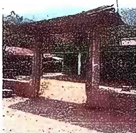
Foto 1: Sustitucion de columnas del portón Modulo 3
