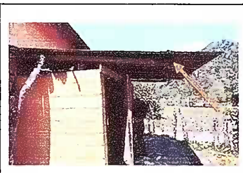
Foto 2: sustitucion de láminas del baño. Modulo 2
