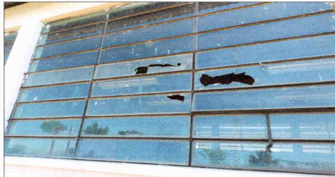
Módulo 1: Sustitución de estructura de metal y vidrios de las ventanas de las aulas del centro educativo
