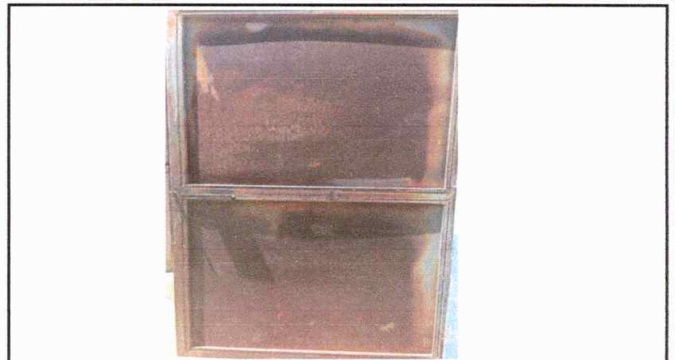
Módulo 1: Sustitución de 4 chapas de las puertas de las aulas del centro educativo
