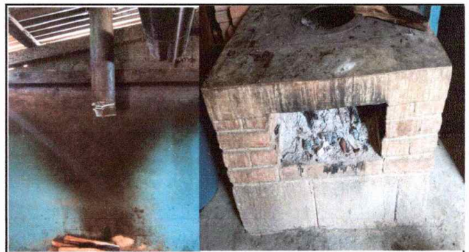
Módulo 3: Sustitución de chimenea y colocación de azulejos a los pollos de la cocina
