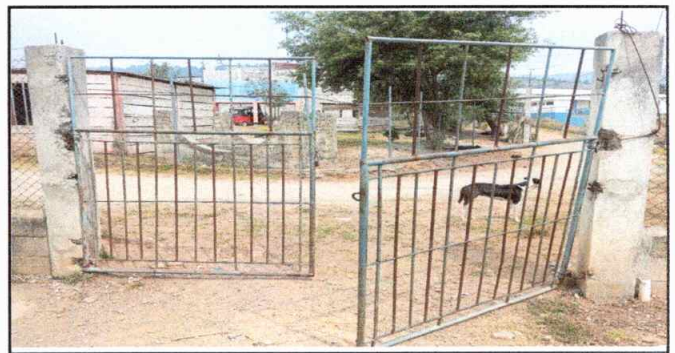
Módulo 4: Sustitución de porton por porton de metal.
