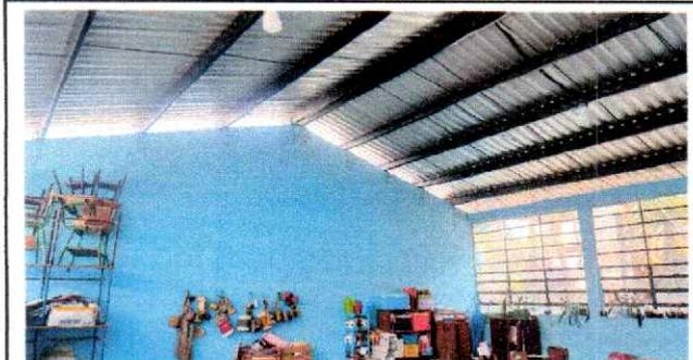
Foto 5: Puede verificarse el remozamiento con cambio de estructura portante de metal, instalación de cubierta de lámina troquelada calibre 26 y mejoramiento de red eléctrica en aula 3, finalizado.
