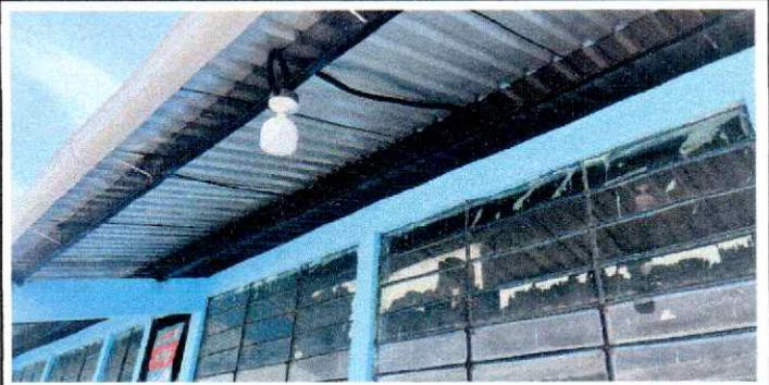
Foto 2: Puede verificarse el remozamiento con cambio de estructura portante de metal, instalación de cubierta de lámina troquelada calibre 26 y mejoramiento de red eléctrica en corredor.
