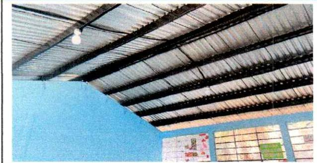
Foto 3: Puede verificarse el remozamiento con cambio de estructura portante de metal, instalación de cubierta de lámina troquelada calibre 26 y mejoramiento de red eléctrica en aula 1.
