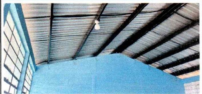
Foto 4: Puede verificarse el remozamiento con cambio de estructura portante de metal, instalación de cubierta de lámina troquelada calibre 26 y mejoramiento de red eléctrica en aula 2.
