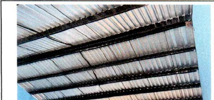
Foto 6: Puede verificarse el remozamiento con cambio de estructura portante de metal, instalación de cubierta de lámina troquelada calibre 26 y mejoramiento de red eléctrica en aula 4, finalizado.
