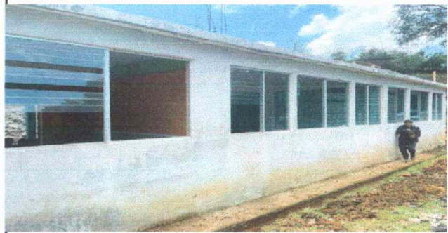
Foto 4: MODULO 2. Reparacion de sillar de ventanas
