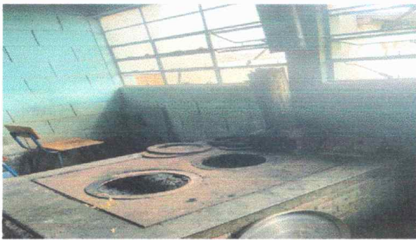
Foto 3: MODULO 1. Sustitucion de estufa Rural (completa) incluye chimenea y plancha de metal
