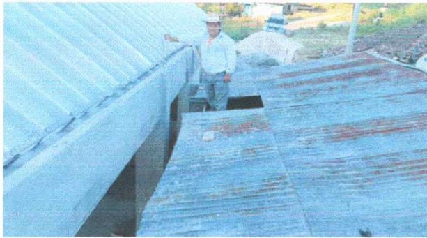
Foto1: MODULO 1. Sustitucion de lamina por lamina troquelada Aluzinc calibre 26
