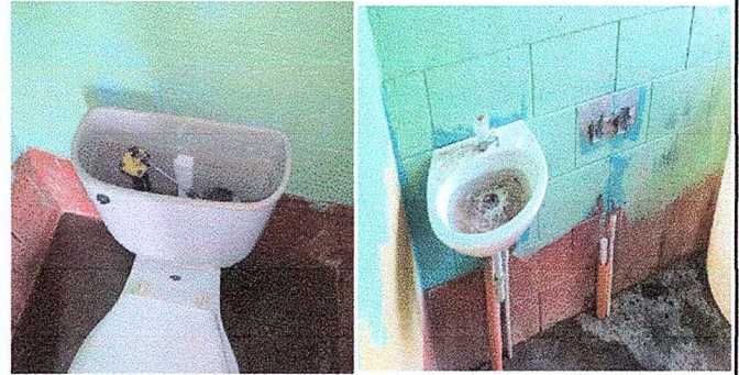
Foto 2: SERVICIO SANITARIOS Sustitución de inodoros y lava manos
