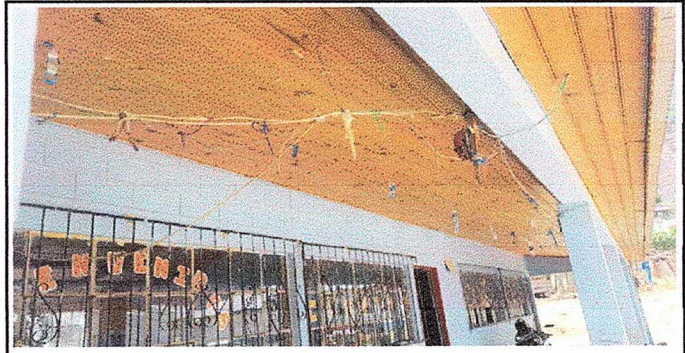
Foto 6: MODULO 3 Reparación de sistema eléctrico.
