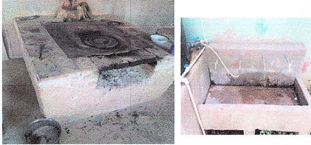
Foto1: COCINA Sustitución de estufa rural (completa) incluye chimenea y plancha de metal sistema eléctrico, llave de chorro. Reparación de ducto eléctrico.
