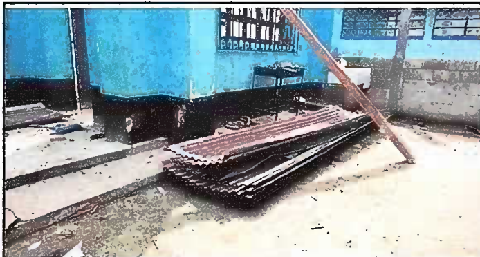
Foto 3: Sustitucion de piso de Torta de Concreto
