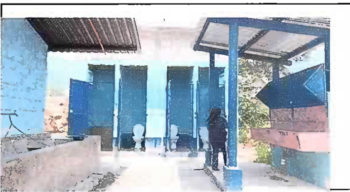
MODULO 3: Foto 1. Reparación de puertas e instalación de chapas, tallado y pintura de paredes.
