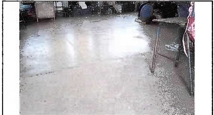
Foto 2: Sustitución de piso en torta por piso cerámico.
