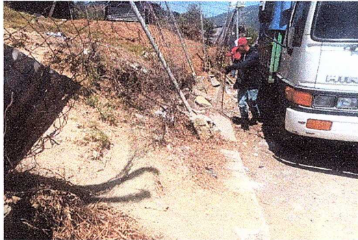
Foto1: Sustitución de muro perimetral de block
