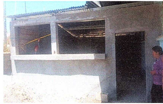
Foto 2: pintura en muror exterior e interior cocina
