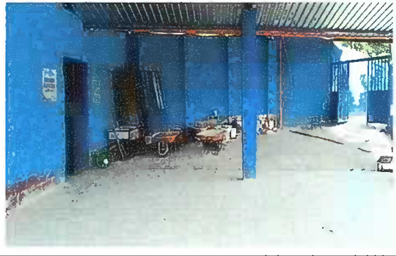
Foto 4: Módulo 2 (Reparación de piso cerámico)
