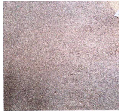
Foto 4: Módulo 2 (Reparación de piso cerámico)
