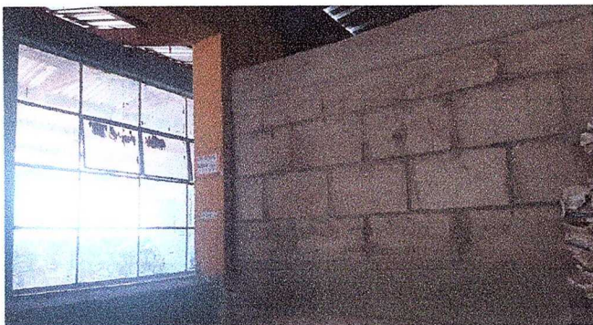
Foto 5: Módulo 2 (Sustitución de ventana de metal)
