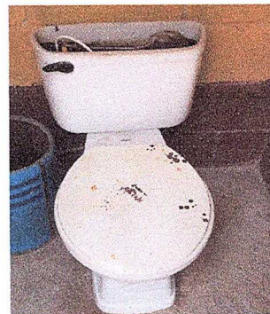
Foto 6: Módulo 3 (Sustitución de inodoro)
