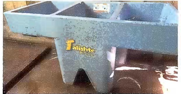
Foto 6: Sustitución de pila 1 lavadero por plastico de 2 lavaderos. PATIO
