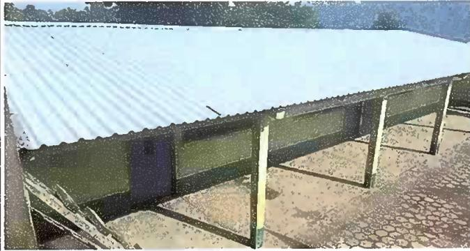
Foto 1: Sustitución de láminas. MÓDULO 1
