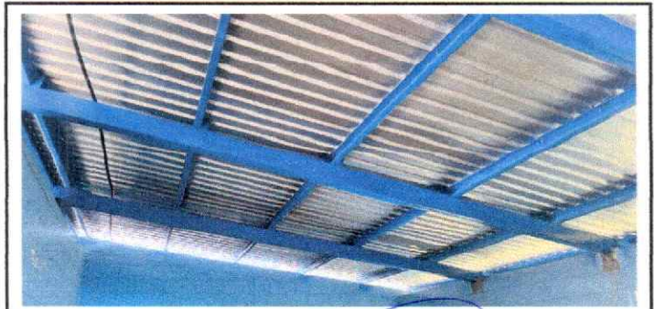
Foto 6: Se ha concluido con la instalación de lámina troquelada calibre 26 en aula 1.
