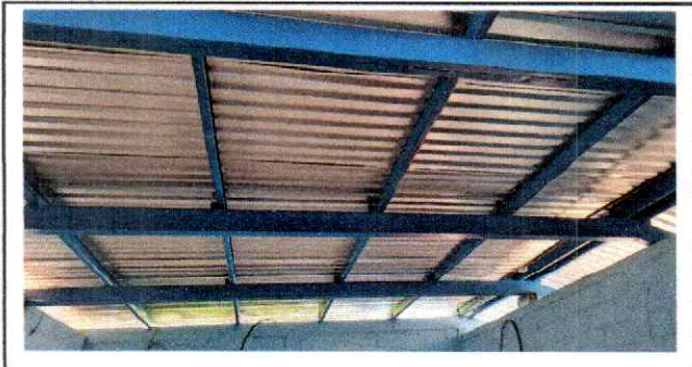
Foto 5: Se ha concluido con la instalación de estructura portante de metal en aula 1.
