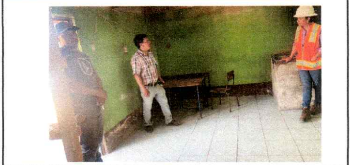
Foto 4: Miembros de OPF expresan el remozamiento realizado en área de cocina, mejoramiento de estufa rural, cambio de piso y mejoramiento de cubierta de lámina troquelada calibre 26.
