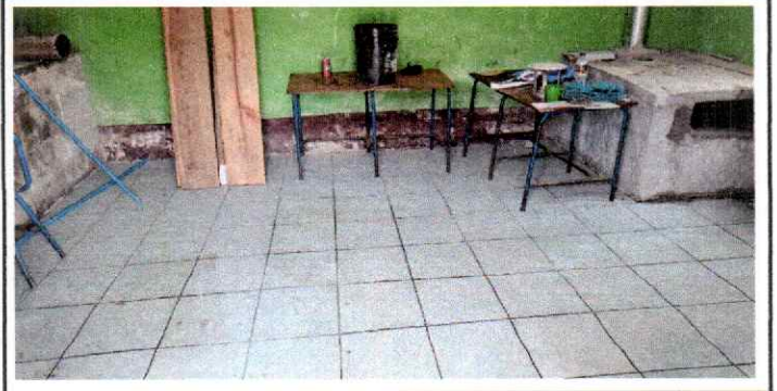
Foto 2: Puede verificarse la instalación de piso en área de cocina, finalizado
