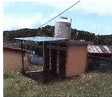
Foto 6: Sustitución de tinaco
