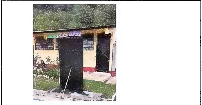
Foto 2: Mantenimiento a estructura (lijado, seplado y aplicación de pintura a puertas de metal)
