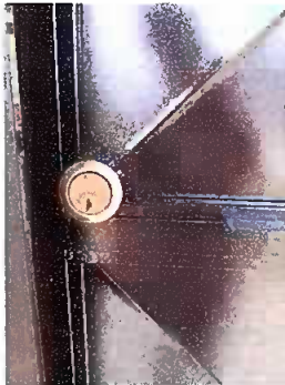
Foto 3: Sustitución de chapa
