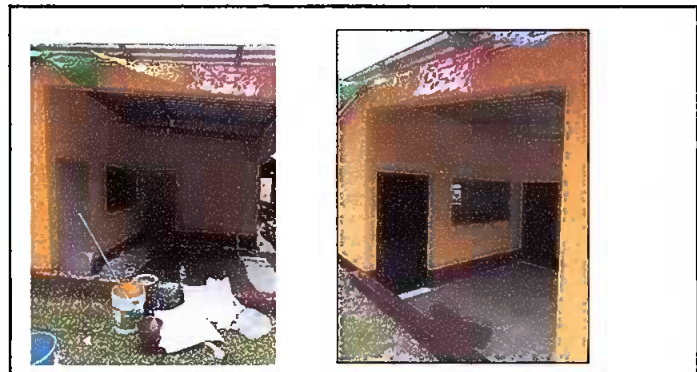
Foto 3: Aplicación de pintura en exteriores de aulas
