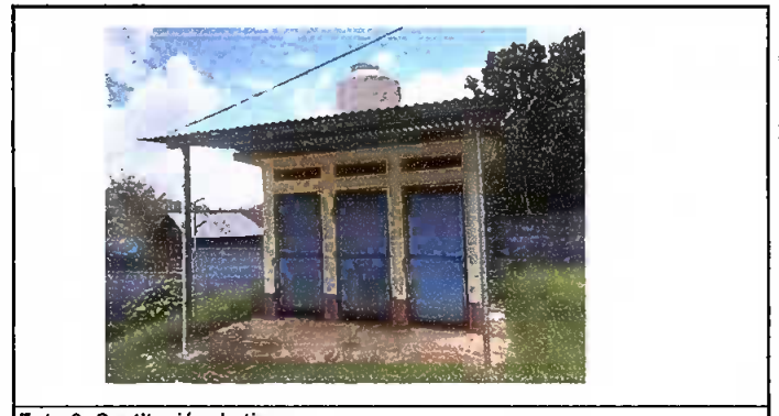
Foto 6: Sustitución de tinaco
