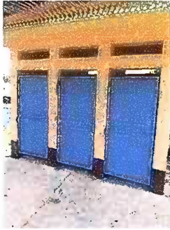
Foto1: Mantenimiento de estructura metálica, pintura de puertas de servicio sanitario 4.1
