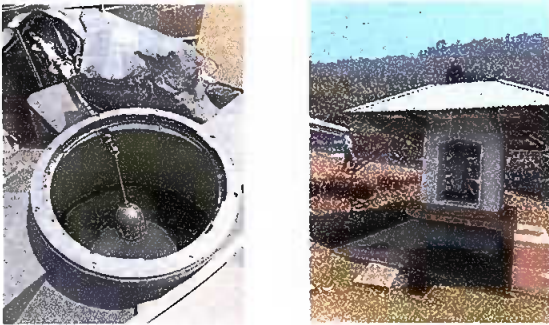
Foto 3: Sustitución de accesorios de depósitos de agua
