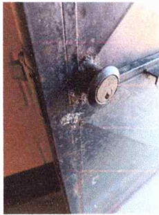
Foto 3: Sustitución de chapa
