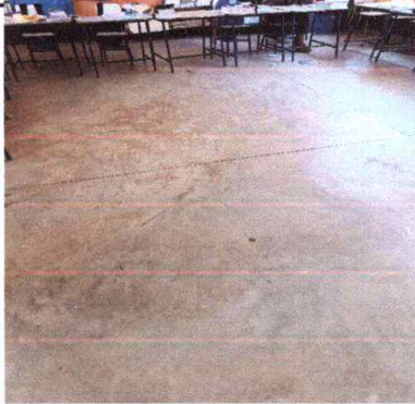
Foto1: Sustitución de piso cerámico
