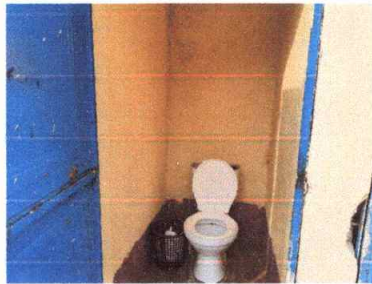
Foto 5: Sustitución de tapadera de sanitarios
