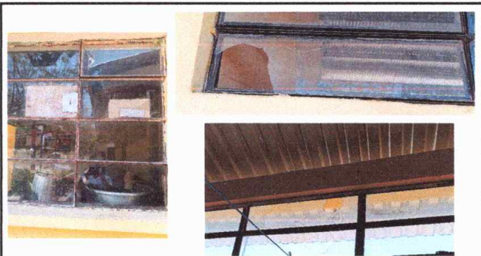
Foto 2: Sustitución de vidrios
