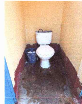
Foto 4: Sustitución de accesorios de inodoro
