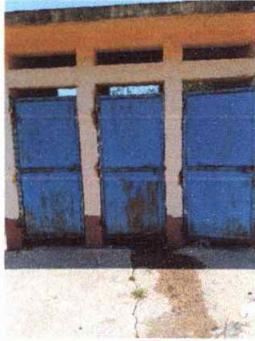
Foto1: Pintura de puertas de sanitarios
