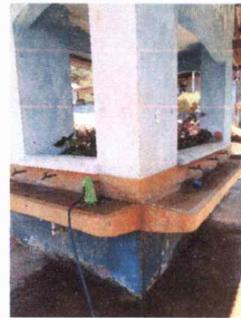
Foto 2: Sustitución de llaves de chorro
