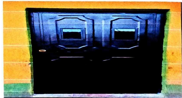
Foto 6: Sustitución de puerta de metal.
