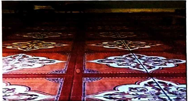
Foto 4: Módulo 2. Sustitución de piso de torta por piso cerámico.
