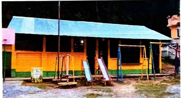
Foto 2: Módulo 1. Instalación de lámina troquelada aluzinc.
