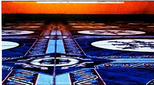
Foto 3: Módulo 1. Sustitución de piso de torta por piso cerámico.
