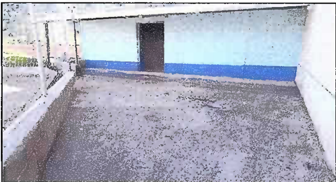
Modulo 2: Foto 2. Plancha de concreto patio y muro.
