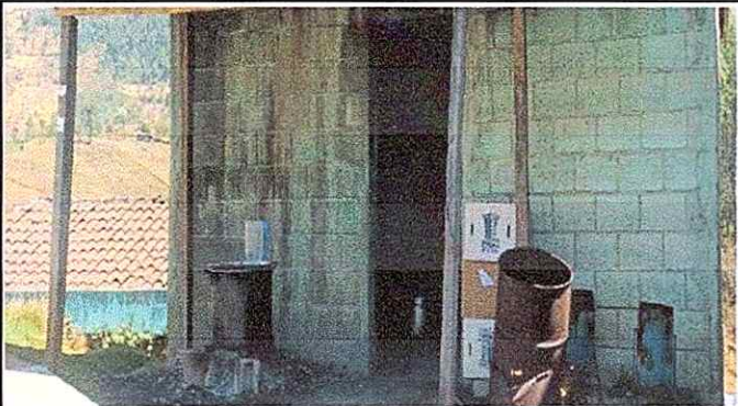
Foto 3: sustitución de muro
