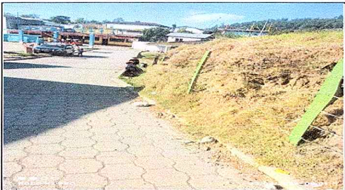
instalacion de maya mas tubo mas solera mas base
