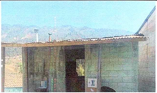
Foto 4: Sustitución de lamina por lamina troquelada y pintura en muros
