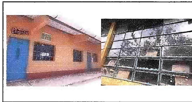
Foto 5: Mantenimiento a estructura de puertas de metal y sustitución de vidrios.
