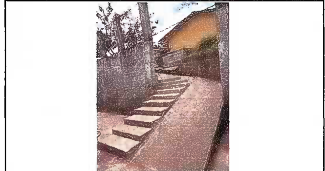
Foto 4: Reparación de rampa de concreto.
