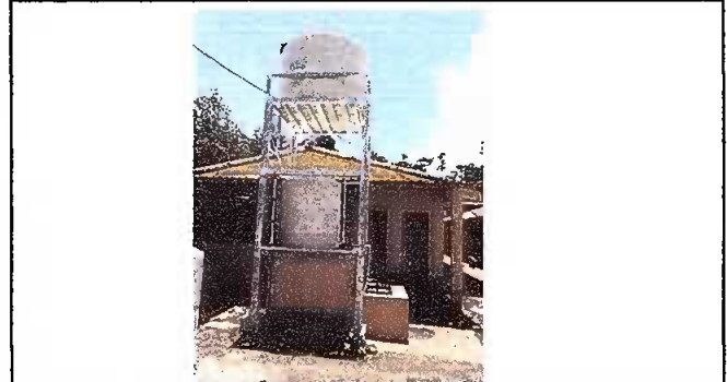
Foto 2: Sustitución de tinaco, reparación de base e instalación de tubería principal y distribución a sanitarios.
