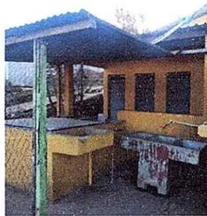
Foto 3: Sustitución de inodoros y sustitución de pila de concreto de dos lavaderos.
