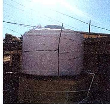
Foto 2: Sustitución de tinaco, reparación de base e instalación de tubería principal y distribución a sanitarios.
