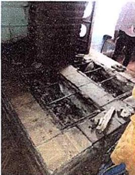
Foto 1: Sustitución de chimenea y reparación de estufas, instalación de agua, pila y energía eléctrica.
