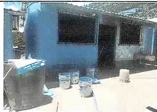
Foto 2. Pintura General. Cocina, se observa pintura en la parte exterior de la cocina.
