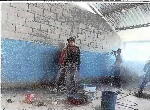
Foto 3. Pintura General. Escenario, se observa la aplicación de la pintura en su primera capa del escenario.
