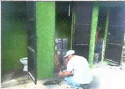
Foto 1. Módulo 3. Inodoro, se observa la instalación de inodoros por el albañil
