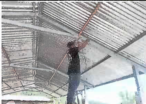
Foto 5. Módulo 4. Cableado eléctrico y accesorios, se observa la instalación del cableado eléctrico más accesorios.
