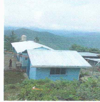
Foto 14: Patio. Se observa el depósito de agua a 15 metros de la cocina, la cocina está en desnivel; por lo que no se abastece, requiere instalación base nueva de depósito de agua de 2,500 It exclusivamente
