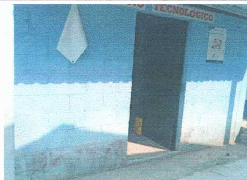
Foto 18: Pintura General. Dirección exterior, se observa que requiere pintura en su totalidad.
