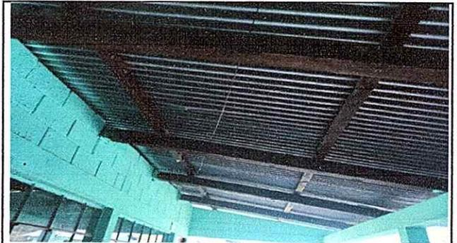
Foto 2: Módulo 2: Sustitución de Soporte de madera
