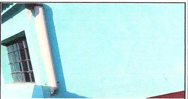
Foto 6: Módulo 2: Sustitución de bajada de agua.
