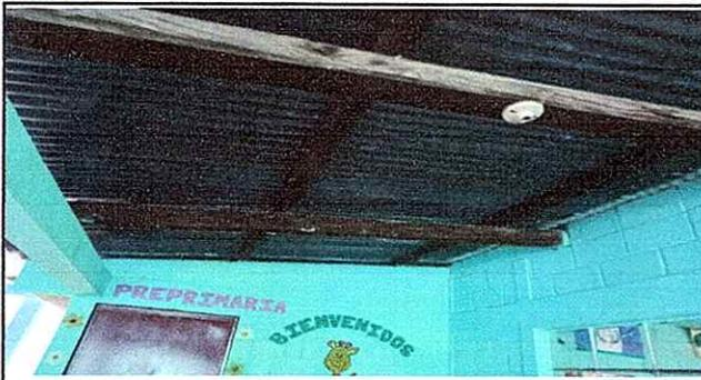
Foto 3: Módulo 2: Sustitución de lámina por lámina troquelada cal. 26
