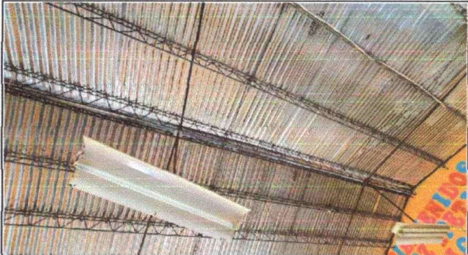
Foto 3: Módulo 1: Mantenimiento de estructura de metal
