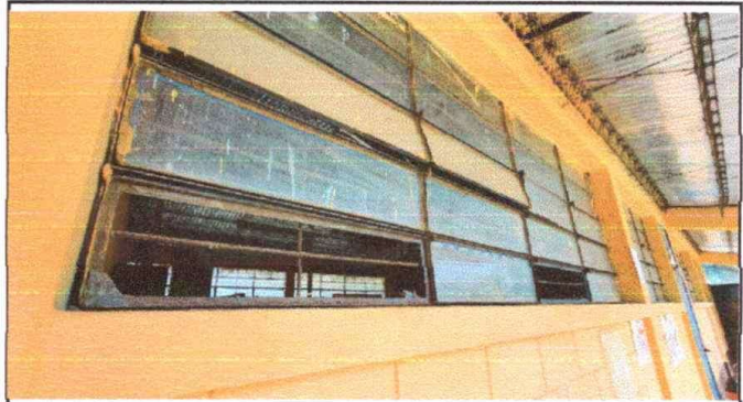
Foto 2: Módulo 1: Sustitución de Vidrios
