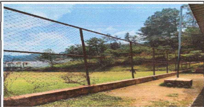
Foto 4:: Reparación de Tubo hg y Malla Galvanizada
