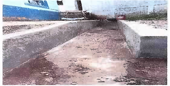
Foto 2: CUNETETA DE CONCRETO
