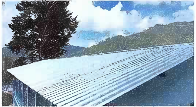
Foto 4: CUBIERTA DE LÁMINA
