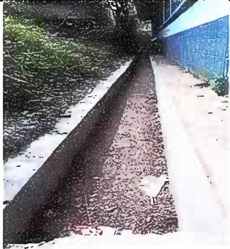
Foto 5: CUNETETA DE CONCRETO
