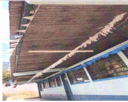
Foto 4: Módulo 2. Sustitución de Lámina
