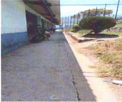
Foto 1: Módulo 1. Reparación de cuneta de concreto
