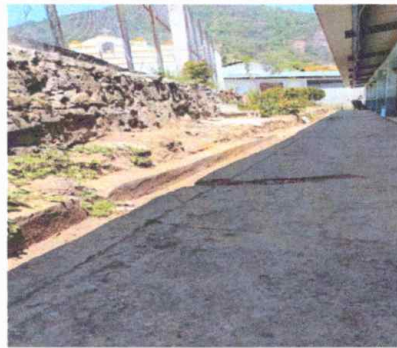
Foto 2: Módulo 1. Reparación de cuneta de concreto
