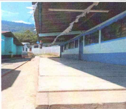
Foto 3: Módulo 2. Sustitución de piso de torta de concreto
