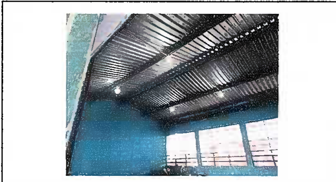
Foto 4: Modulo 2 (Sustitución de iamparas 2x40)
