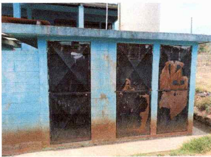
Foto 5: Modulo 3 (Reparación de puertas de servicios sanitario)
