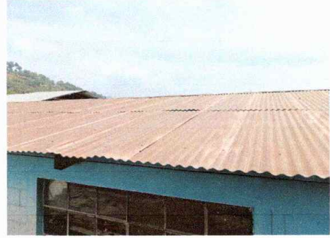
Foto 2: Modulo 1 (Sustitución de lámina)
