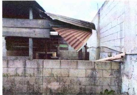
**Módulo 1: Sustitución de lámina, por lámina troquelada aluzinc calibre 26**
