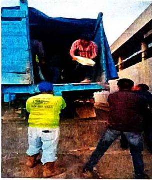
Foto 1: Recepción de piso y materiales
