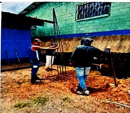
Foto 5: MODULO 1: Reparación de muro de contención
