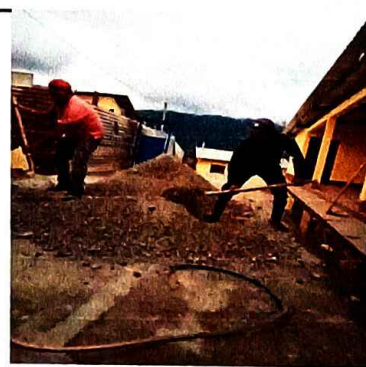
Foto 6: MODULO 1: Fundición de muro de contención.
