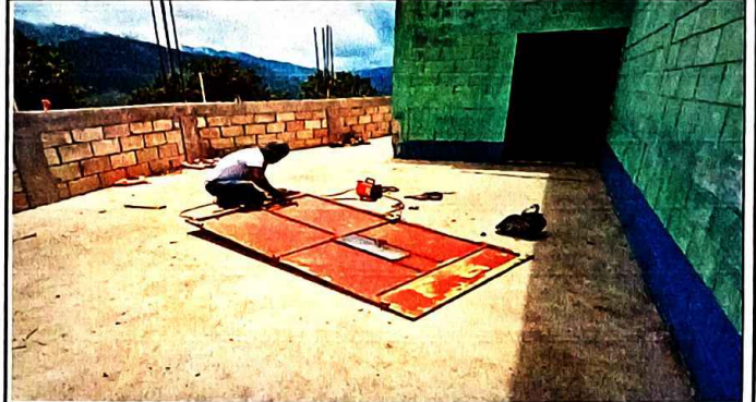
Foto 2 Reparación de puertas
