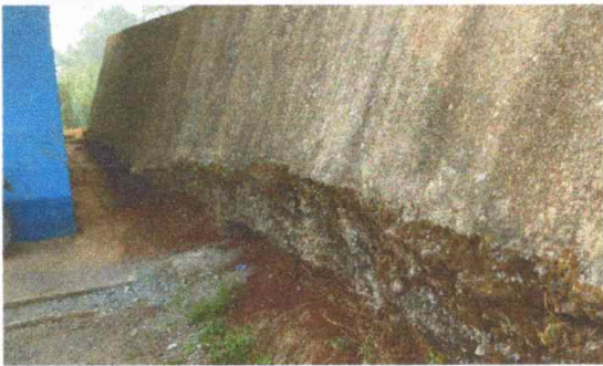
Foto 5: MODULO 1: Reparación de muro de contención
