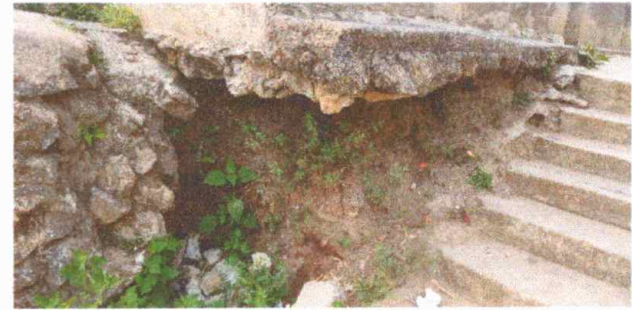
Foto 4: MODULO 1: Reparación de muro de contención.
