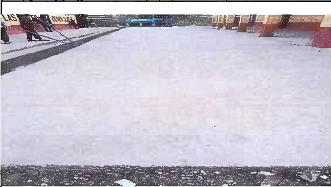
Foto 3: pavimento de patio
