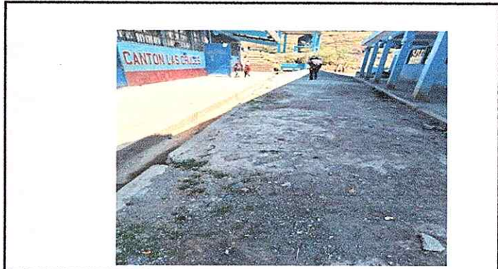
Foto 2: REPARACIÓN DE TORMA DE CONCRETO
