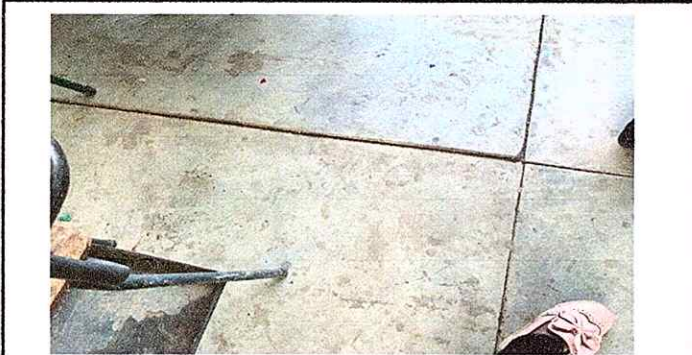
Foto 3: SUSTITUCIÓN DE TORMA DE CONCRETO POR PISO CERAMICO.
