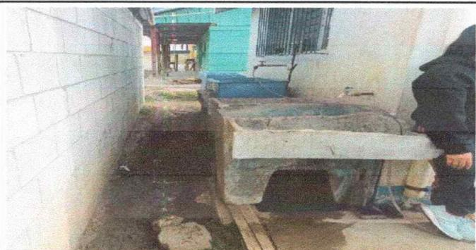
Foto 4: SUSTITUCION DE PILA MAS TUBO PVC DE AGUAS NEGRAS Y AGUA ENTUBADA
