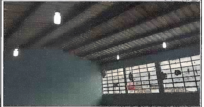
Foto 2: MODULO 1. Sustitución de focos ahorradores
