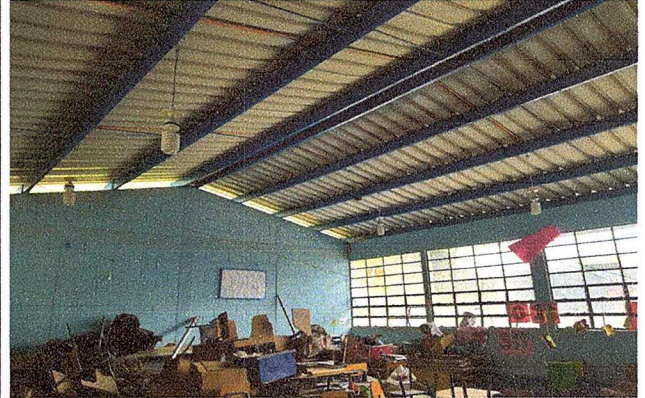
Foto 2: MODULO 1. Sustitución de focos ahorradores
