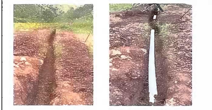
Foto 5: Instalación de tubería para traslado de aguas negras a otra fosa.
