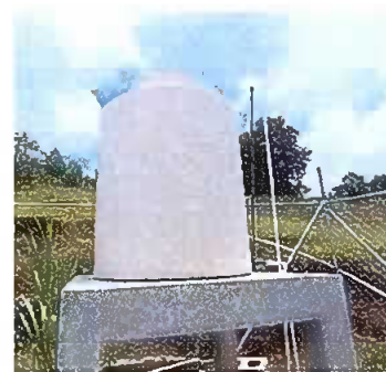
Foto 4: Sustitución de tinaco.
