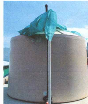
Foto 4: Sustitución de tinaco, en mal estado.
