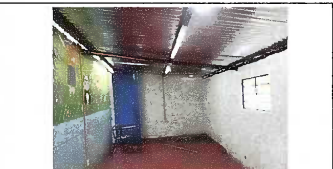
Foto 4: sustituir de piso, reparacion de cableado electrico, sustitución de ventana
