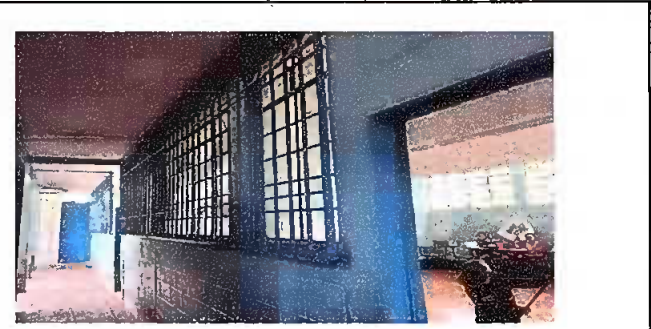
Foto 2: sustitución de balcones, sustitución de vidrios, sustitucion de lamparas.
