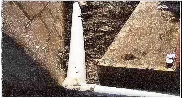
Foto 2: Reparación de cuneta en el Patio con tubo de PVC de 4plg.
