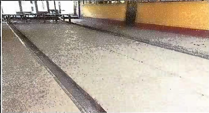
Foto 1: Emparejar con torta de cemento en el corredor de las aulas y tubería de drenaje.
