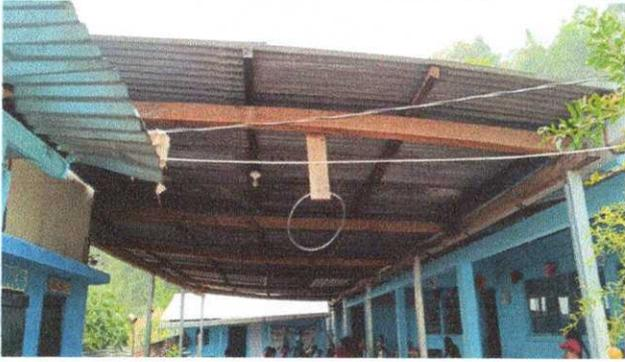
Patio: Foto 1, Sustitución de lámina por lamina troquelada aluzinc calibre 26.
