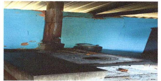
Modulo 3: Foto 4, Sustitución de estufa rural (completa) Incluye chimenea y plancha de metal.
