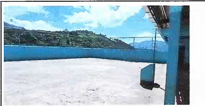
Foto1: Pinturas de muros interiores y exteriores.
