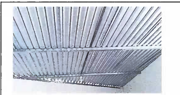
Foto 5: Sustitucion de lamina troquelada aluzinc calibre 26
