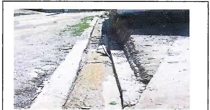
Foto 2: Reparacion de coneta de concreto
