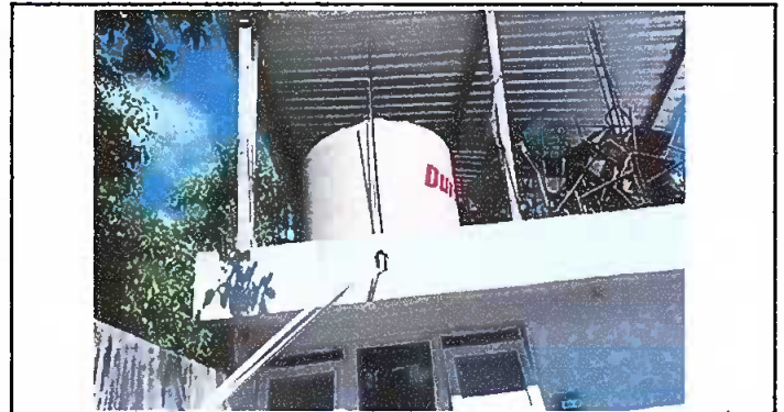
Foto 4: Sustitución de depósito de agua de 2500 Lt.
