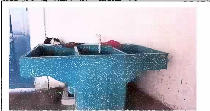
Foto 3: Sustitucion de pla de concreto
