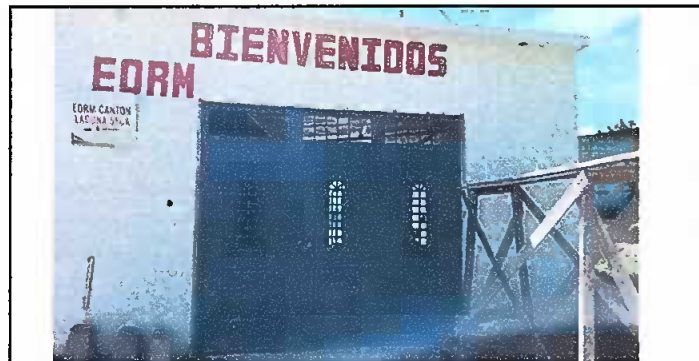
Foto 5: Suministro e Instalación de portón de metal de ingreso.
