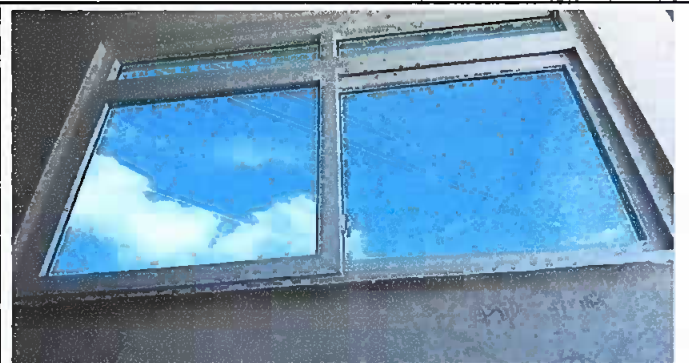
Foto 2: Suministro e instalación de ventana PVC 190x125
