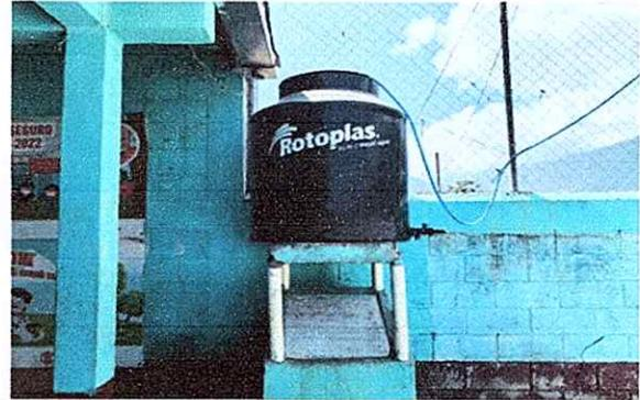
Foto 2: Sustitución de depósito de agua de 2,500 lts.
