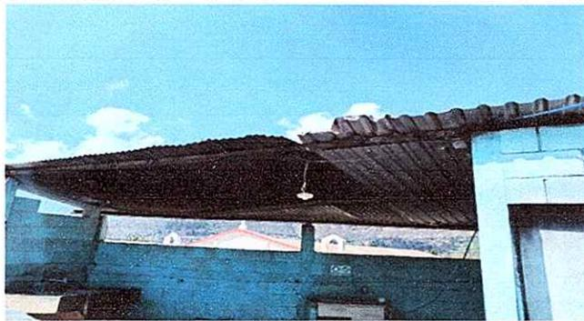
Foto 5: Sustitución de lámina troquelada alizinc calibre 26
