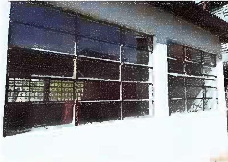
Modulo 1: Instalación de pedazos de vidrios en ventanas
