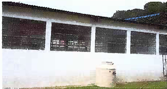
Modulo 1: Repello en paredes de aulas
