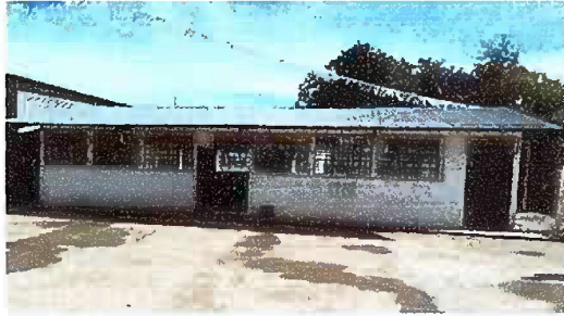
Modulo 1: Repello en paredes de aulas
