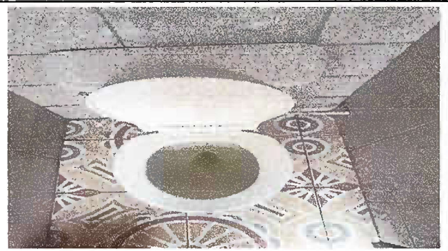
Foto 8: Sustitución de tapadera sanitario
