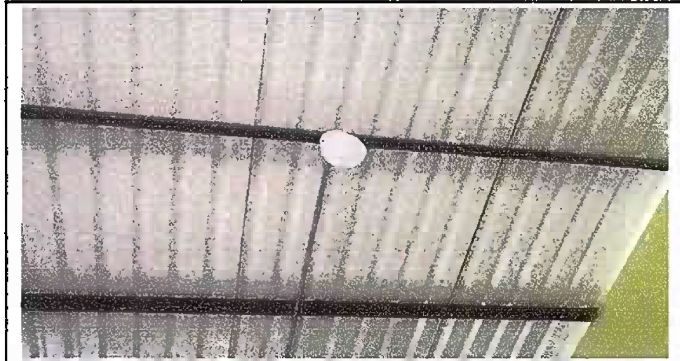
Foto 6: Sustitución de focos ahorradores
