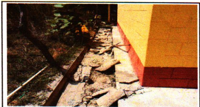
Foto 4: Reparación de cuneta de concreto
