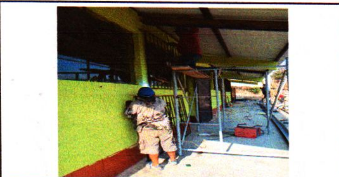
Foto 5: Mantenimiento a balcones de metal
